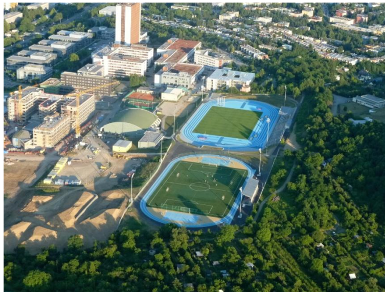
Stav stavby z června 2011
