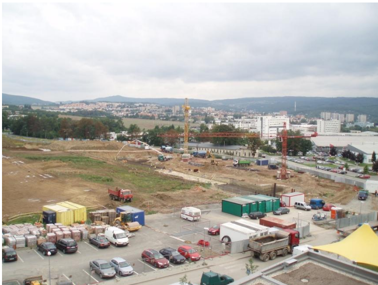
Snímek ze zahájení stavby v září 2010
