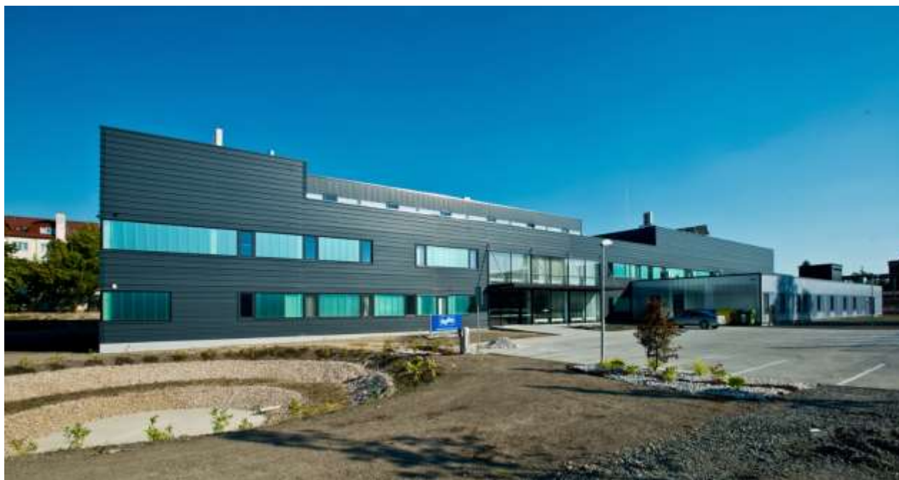
Čelní pohled na budovu v Čelákovících
