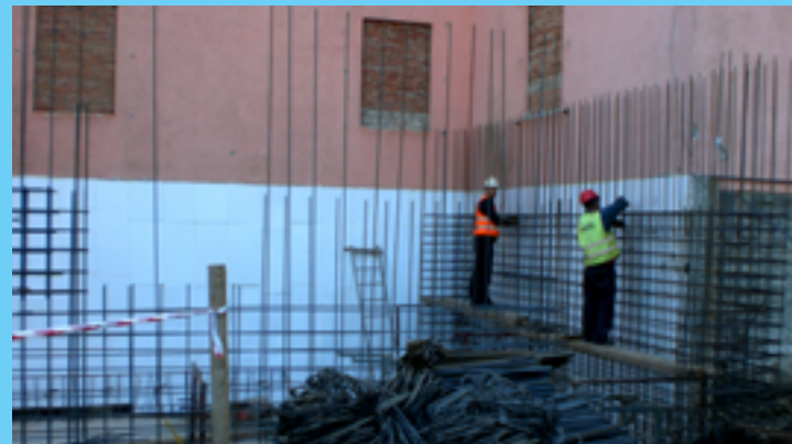
Stavba budovy 17 Centrálního depozitáře v Litoměřicích
