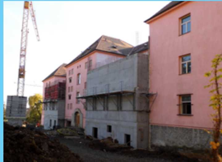
Pohled na budovu 17 (Knihovna, Umělecké sbírky) Centrálního depozitáře v Litoměřicích
