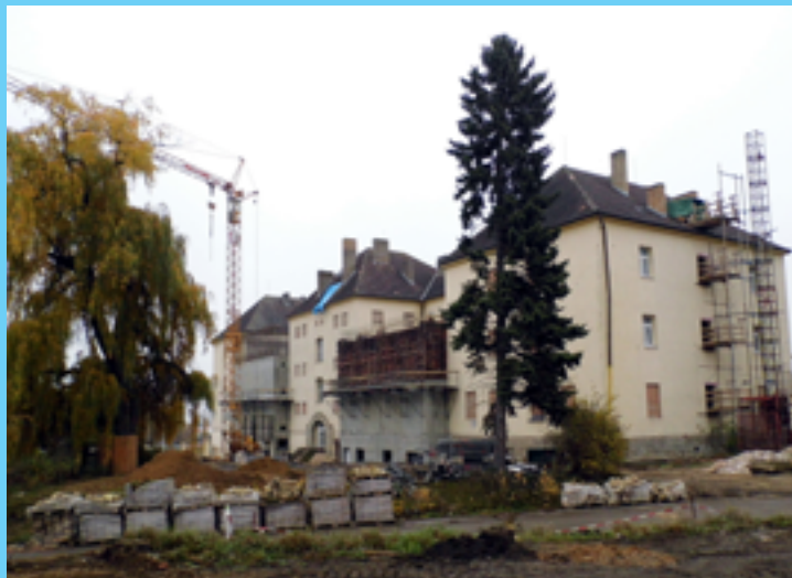
Stavba budovy 21 Centrálního depozitáře v Litoměřicích
