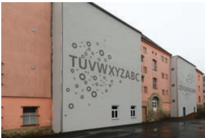
Centrální depozitář v Litoměřicích, budova SO.017 – pohled zepředu
