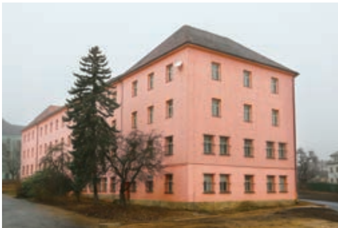
Centrální depozitář v Litoměřicích, budova SO.017 – boční pohled
