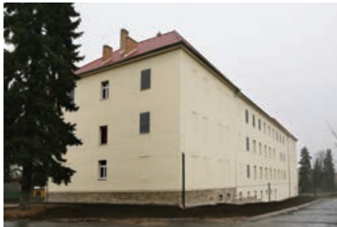
Centrální depozitář v Litoměřicích, budova SO.021 – pohled zezadu
