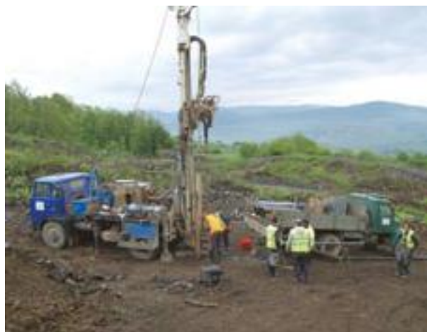
Vrtný průzkum sesuvu na dálnici D8 probíhal pod supervizí ČGS v dubnu a květnu 2014.
