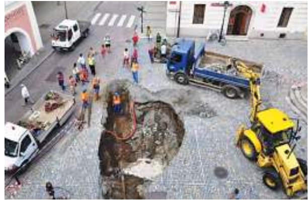
■ Sanační práce na propadu staré šachty v Šultysově ulici v Kutné Hoře (2012).
