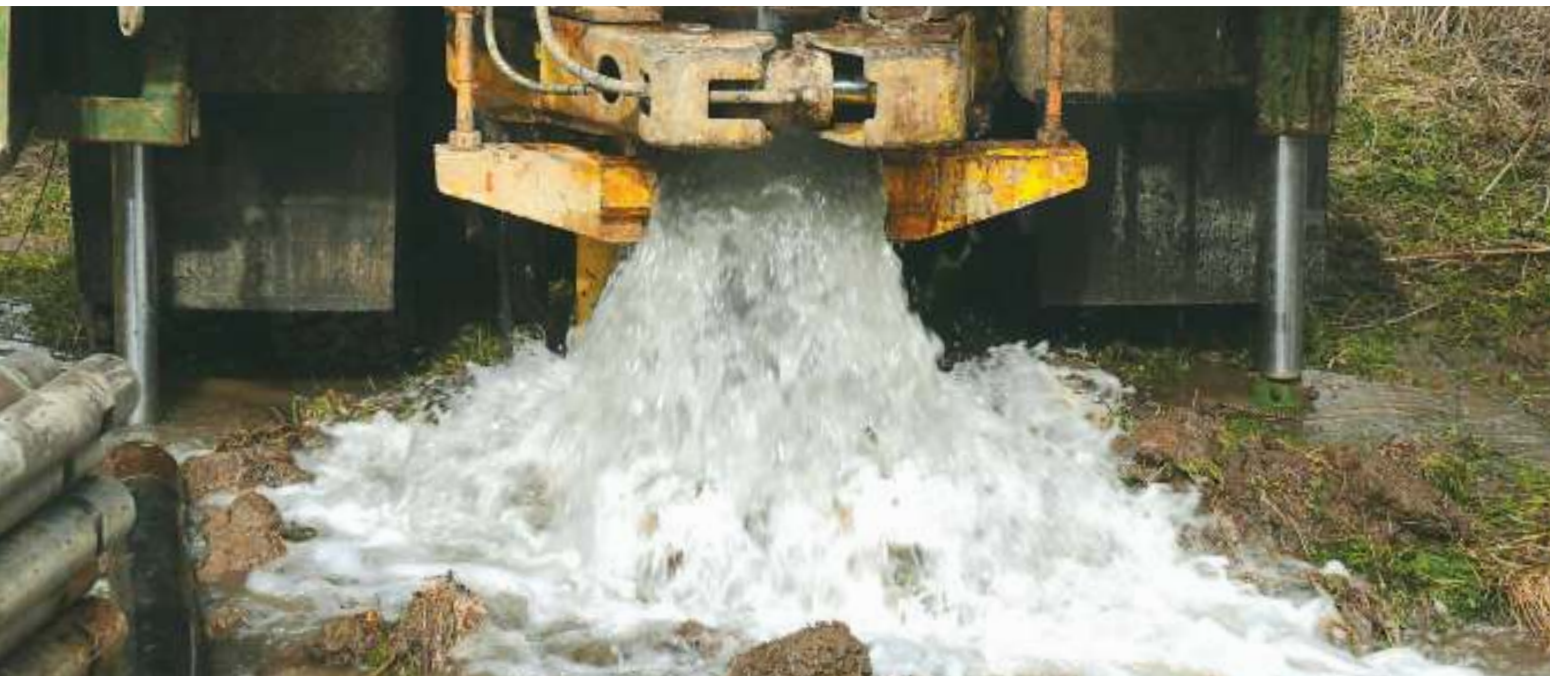
Přetok podzemní vody z kolektoru A2 v Polické pánvi. Hydrogeologický vrt 4110 03AT Velké Petrovice, vyvrtaný v rámci projektu Rebilance zásob podzemních vod , vydatnost cca 20 l/s. Foto P. Čáp.
