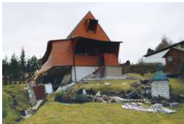
■ Dům v Polákách poškozený sesuvem.
