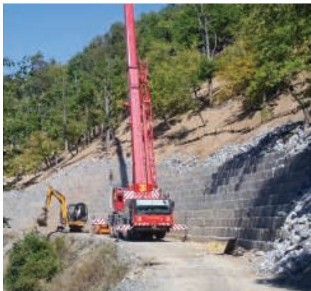
Sanace strmých erozních svahů v levobřežní části přehrady Klíčava v Lánské oboře.
