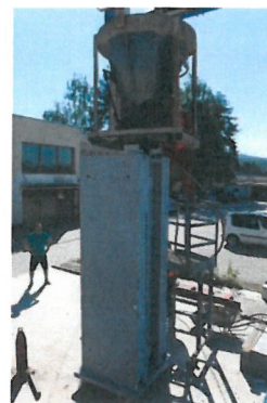
Betonáž kompozitního stojanu obráběcího stroje
