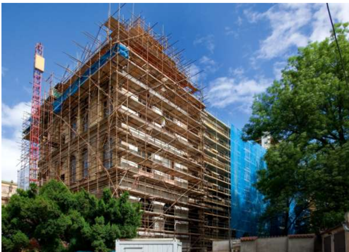
Historická budova Uměleckoprůmyslového musea prochází kompletní rekonstrukcí
