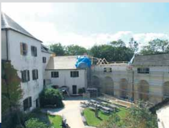
Stavební práce nad Velkým ochozem
