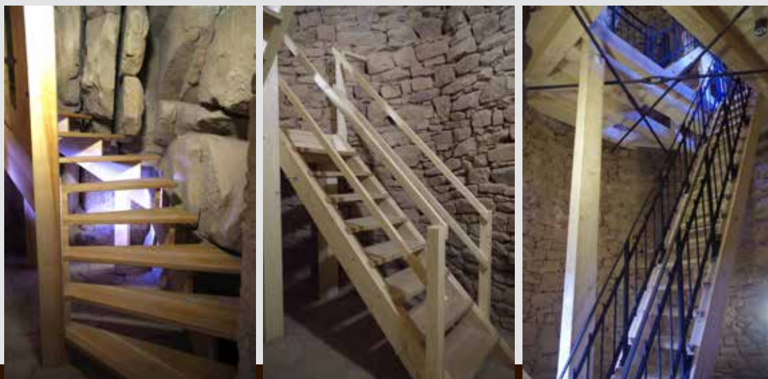
Instalace schodů a zábradlí v hradní věži
