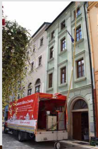
Zateplování půdy na budově 55 v Jihlavě
