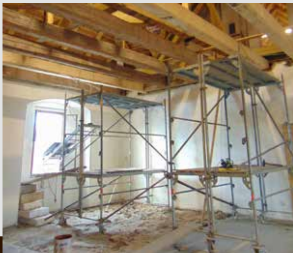
Pohled do hodovní síně během prací
